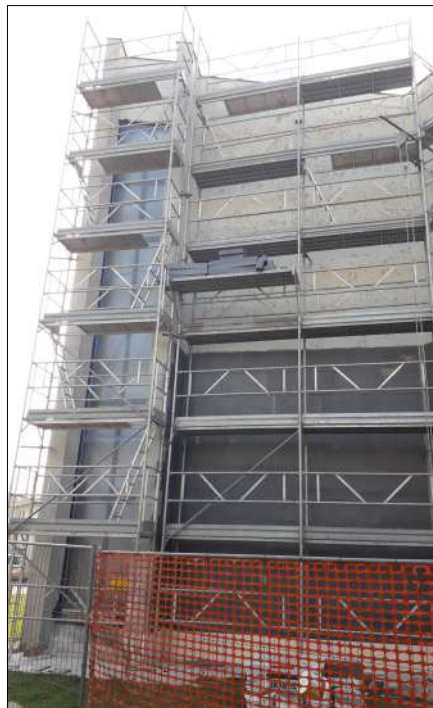
Lavori di realizzazione del cappotto termico dopo la sostituzione dei serramenti.
