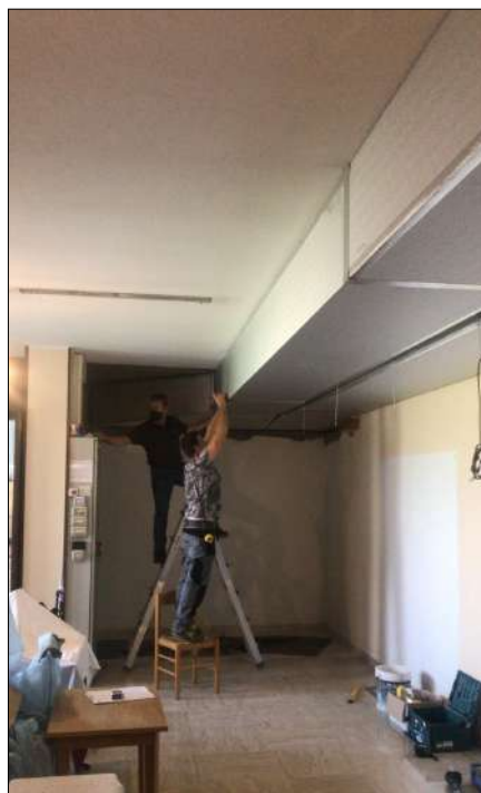
Installazione dei canali di mandata in Sacrestia.
