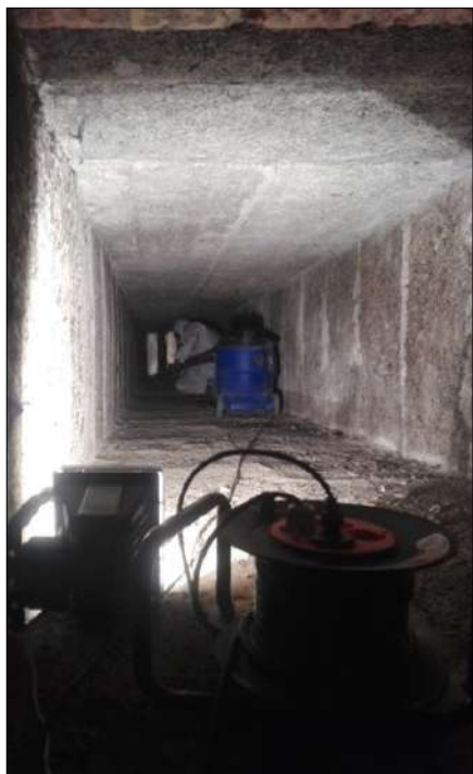
Sanificazione del canale di ripresa presente sotto la pavimentazione.
