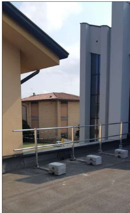
Nuova linea vita zona copertura piana resa obbligatoria per le future manutenzioni.
